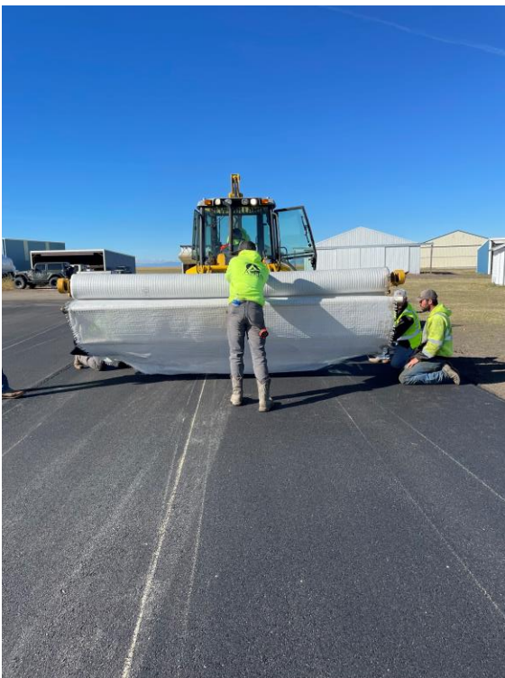
Paving Mat Laydown
