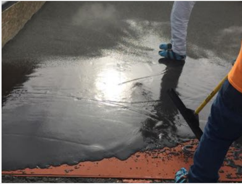
Step 3 Apply Slurry
