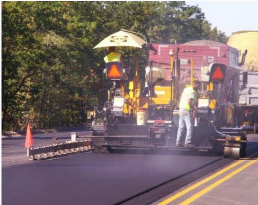
Hot Mix Asphalt
