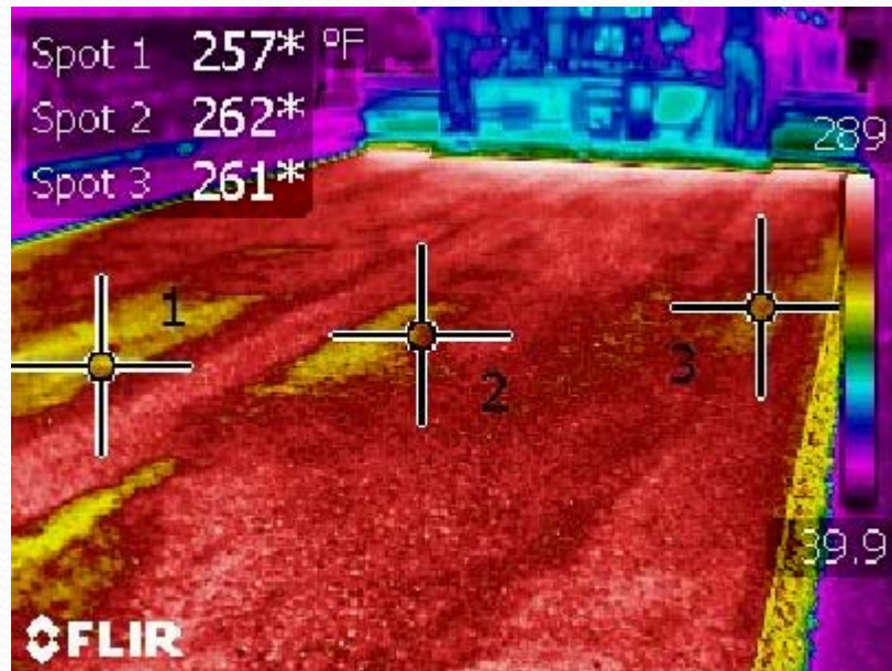
Hot Mix Asphalt
