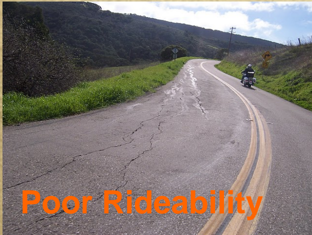
Thermal Cracking
